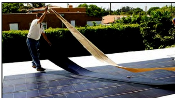
شکل ۱۰- آرایه خورشیدی لایه نازک و انعطاف‌پذیر سیلیکون آمورف در حال پهن شدن روی پشت بام
